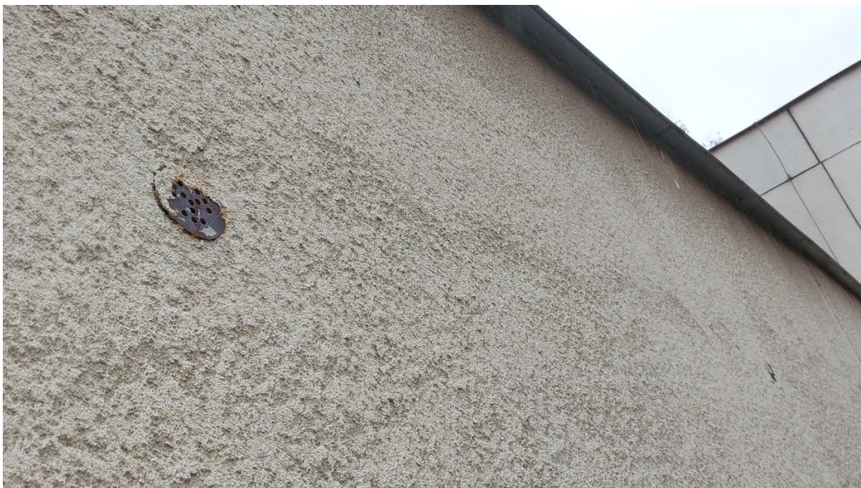
Obr. č. 3 – Otvory v atice jsou opatřeny funkční mřížkou.
